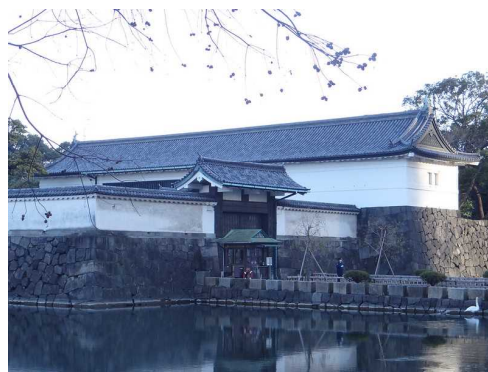
奥：大手門 手前：下乗橋
